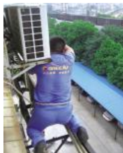
图为奋战在一线的湖南安装工
